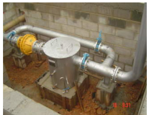
Detalhe do Dreno de Sedimentos.
